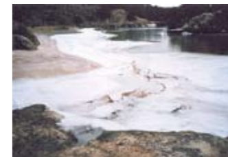
Kollevågen, Hordaland. Bildet viser hvordan bølger har gravd seg inn i deponiet. Lokaliteten er i dag ryddet opp, men det gjenstår et deponi på stedet. (Foto: Instanes AS)
